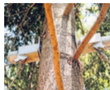
ANCLAJE. El sistema de sujeción no daña a los árboles y permite su crecimiento.
